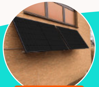
ติดตั้งกำแพงบ้าน
