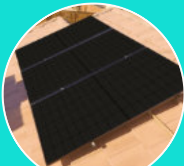
ติดตั้งบนหลังคา
