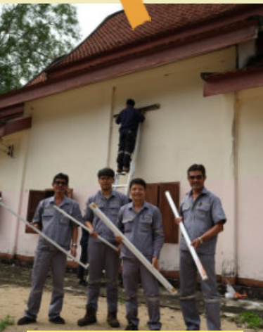
พีปรีชา แก้วทิพย์ นำทีมมาร่วมซ่อมแซมระบบไฟฟ้า
